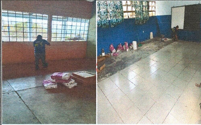
Foto 1: Mejoramiento de piso (instalación de azulejo)
