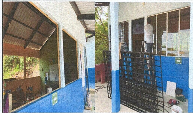
Foto 2: Mejoramiento de ventanas (instalación de ventanas tipo paleta, de vidrio y aluminio con balcones de metal)
